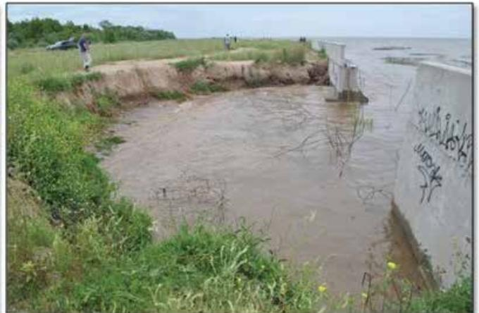
Figura 39. Obra sobre la ribera que altera la dinámica de la costa de Berazategui generando erosión severa.
