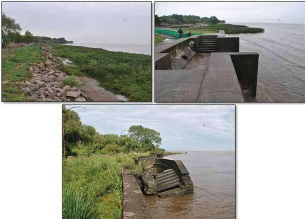
Figura 43. Frente costero en diferentes puntos con Muy Alta vulnerabilidad a la erosión, se observan defensas de piedras y murallones.
