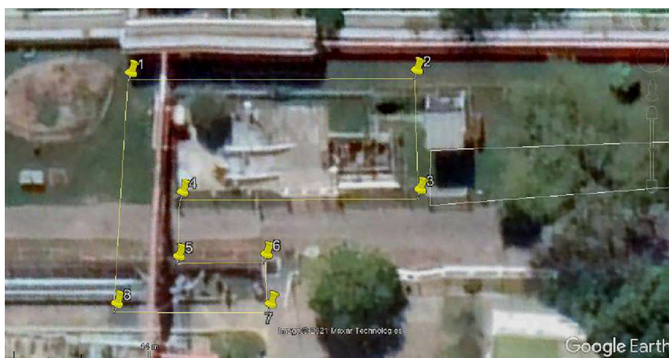
Imagen 1 Sitio de afectación de la obra
