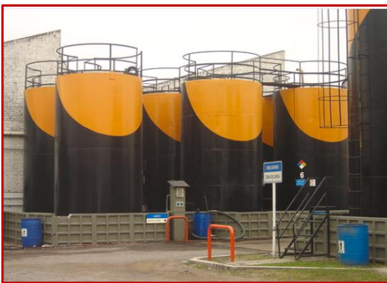
Tanque de emulsiones confinados bateas hormigón, a fin de contener el producto en caso de derrames o pérdidas.
