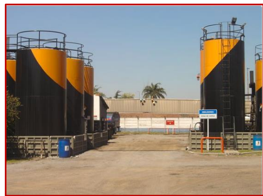
Tanque de emulsiones confinados bateas hormigón, a fin de contener el producto en caso de derrames o pérdidas.
