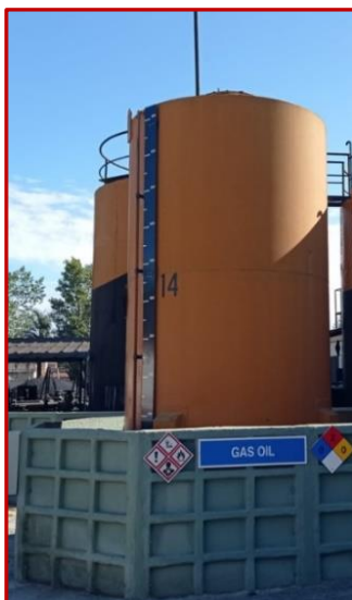
Tanque de emulsiones confinados bateas hormigón, a fin de contener el producto en caso de derrames o pérdidas.
