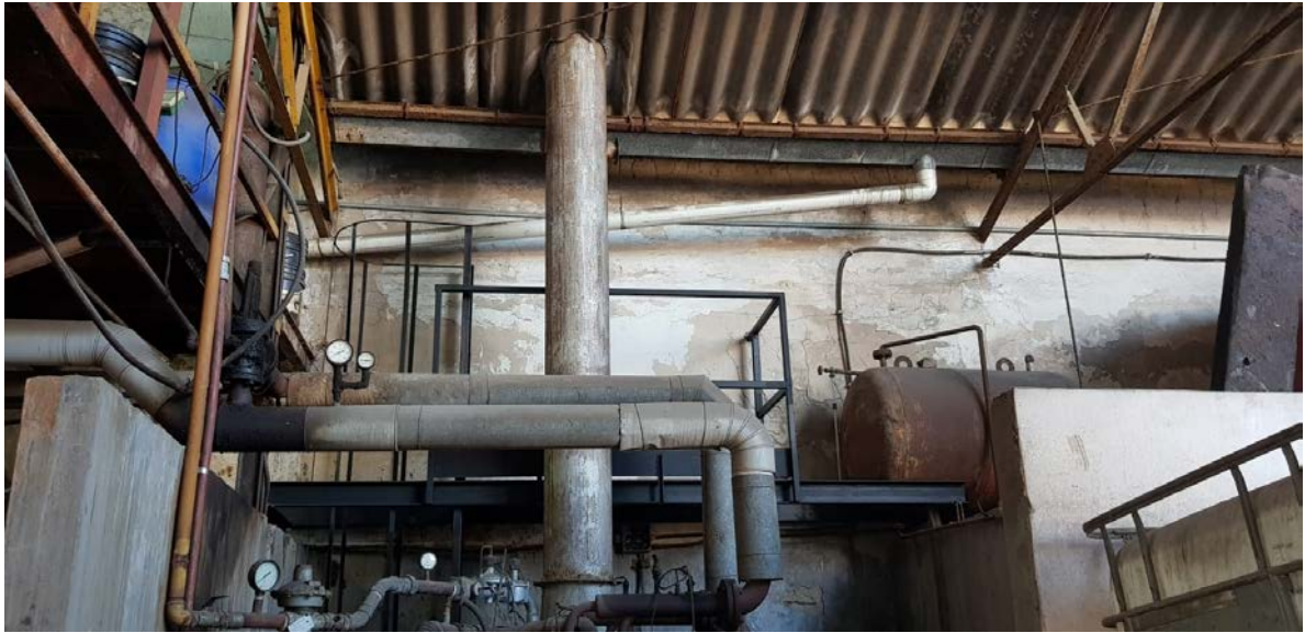
Escalera con guarda hombre, barandas y guardapiés. Orificios de TM. Caldera Fluido Térmico
