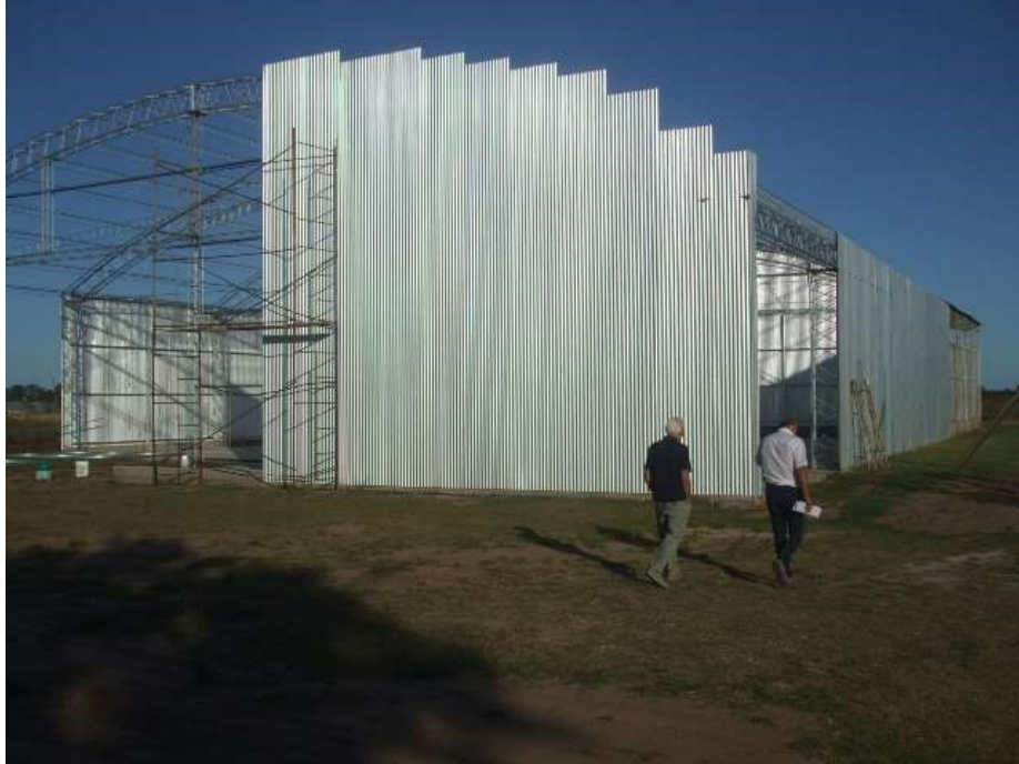
Planta (en construcción).
