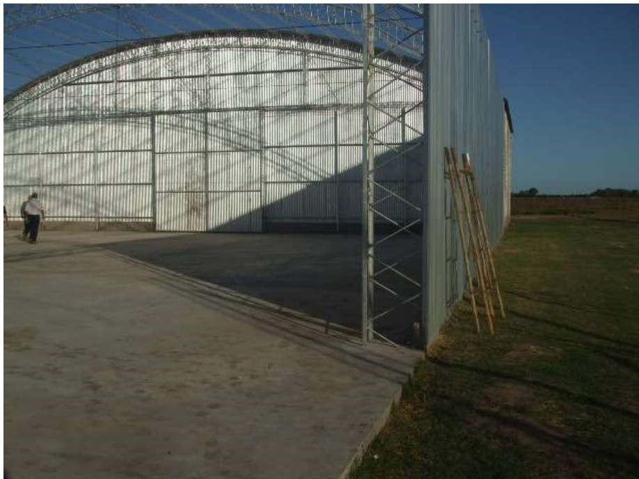
Planta (en construcción).
