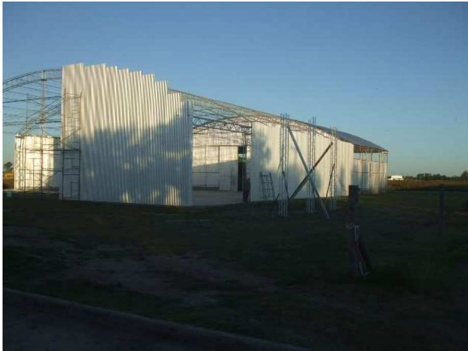
Planta (en construcción).
