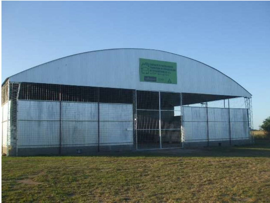
Planta (en construcción).
