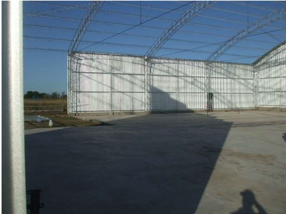
Planta (en construcción).
