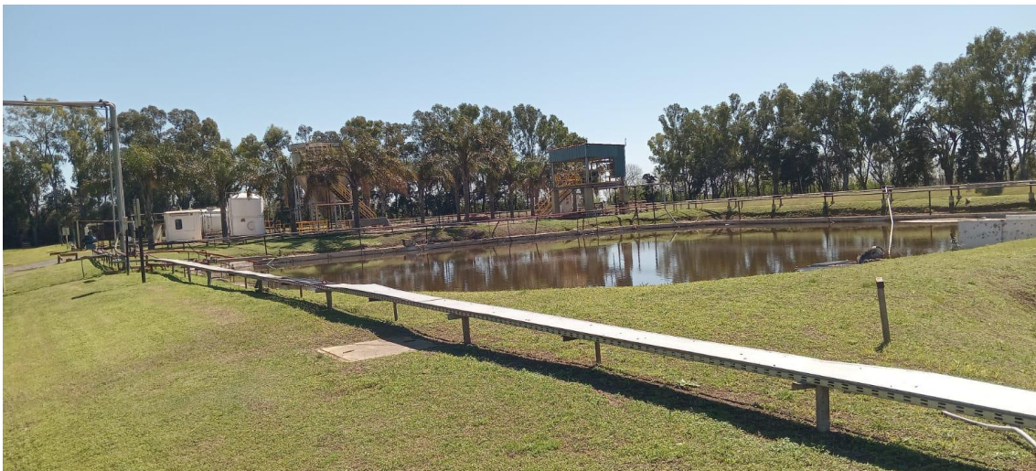
Planta de tratamiento de efluentes líquidos y cámara de aforo.
