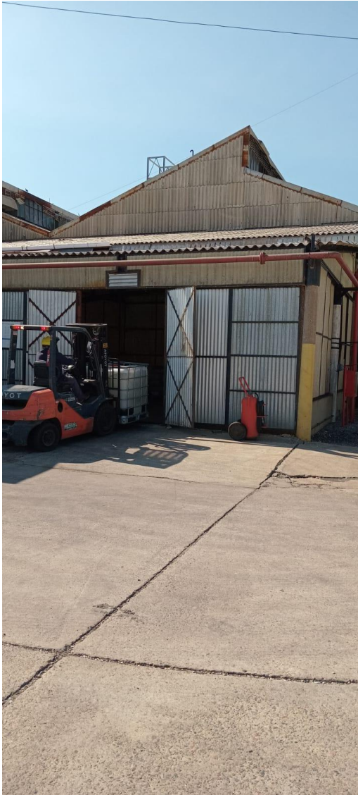
Lugar de almacenamiento de residuos especiales
