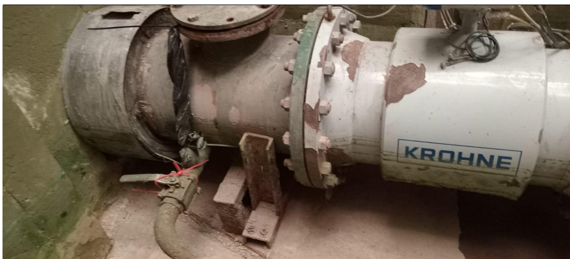
ZONA INTERIOR DE CAMARA DE AFORO
