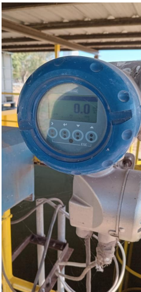
CAUDALIMETRO DE CAMARA DE AFORO
